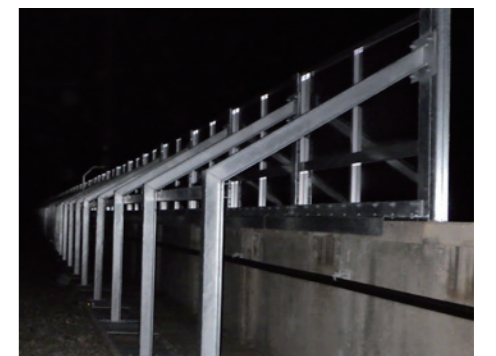
新幹線透光板新設
